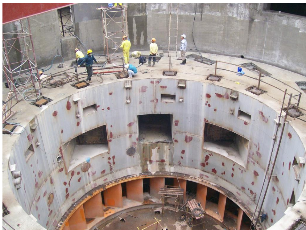
- XỬ LÝ NỨT BÊ TÔNG VÀ RÒ RỈ NƯỚC -THỦY ĐIỆN SƠN LA
